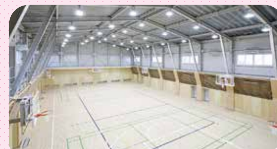
アリーナ(新体育館) シンプルかつ使い勝手の良い導線を確保し、省エネ性に配慮した空調完備の最新の体育館です。
